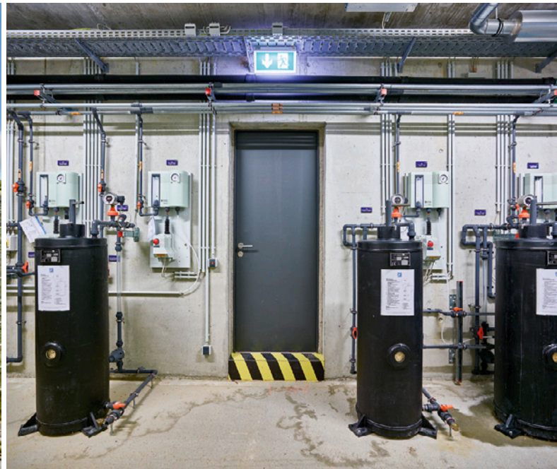
Eine schmale Zugangstür führt vom Gebäudeinneren zum Technikraum.
