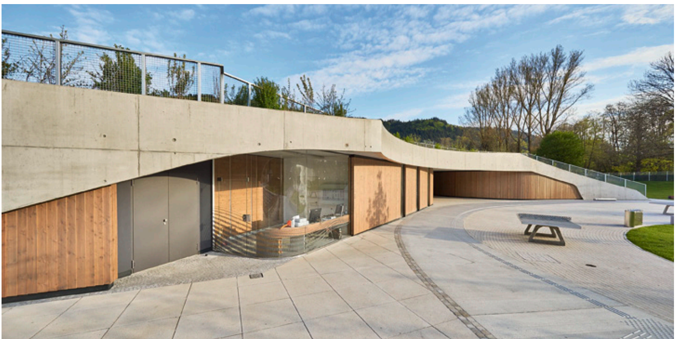
Die doppelflügelige Stahlblechtür von Hörmann führt von der Badseite aus zum Technikraum. Gleich nebenan: das Büro der Bademeister.
