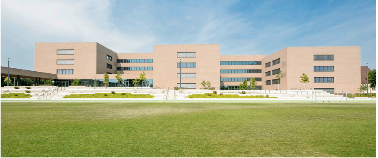
Entsprechend den drei Fachrichtungen gliedert sich das Gebäude in drei Flügel.
