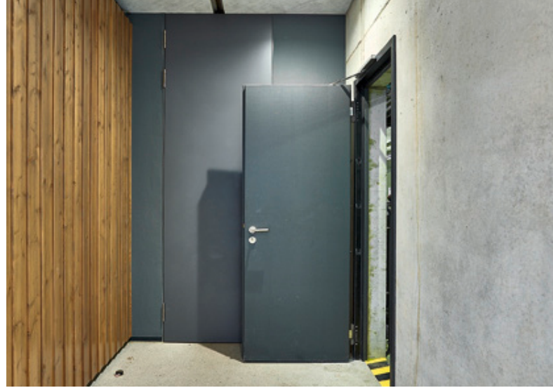
Materialmix: Holzvertäfelung, Betonwand und anthrazitfarbene Stahlblechtür.
