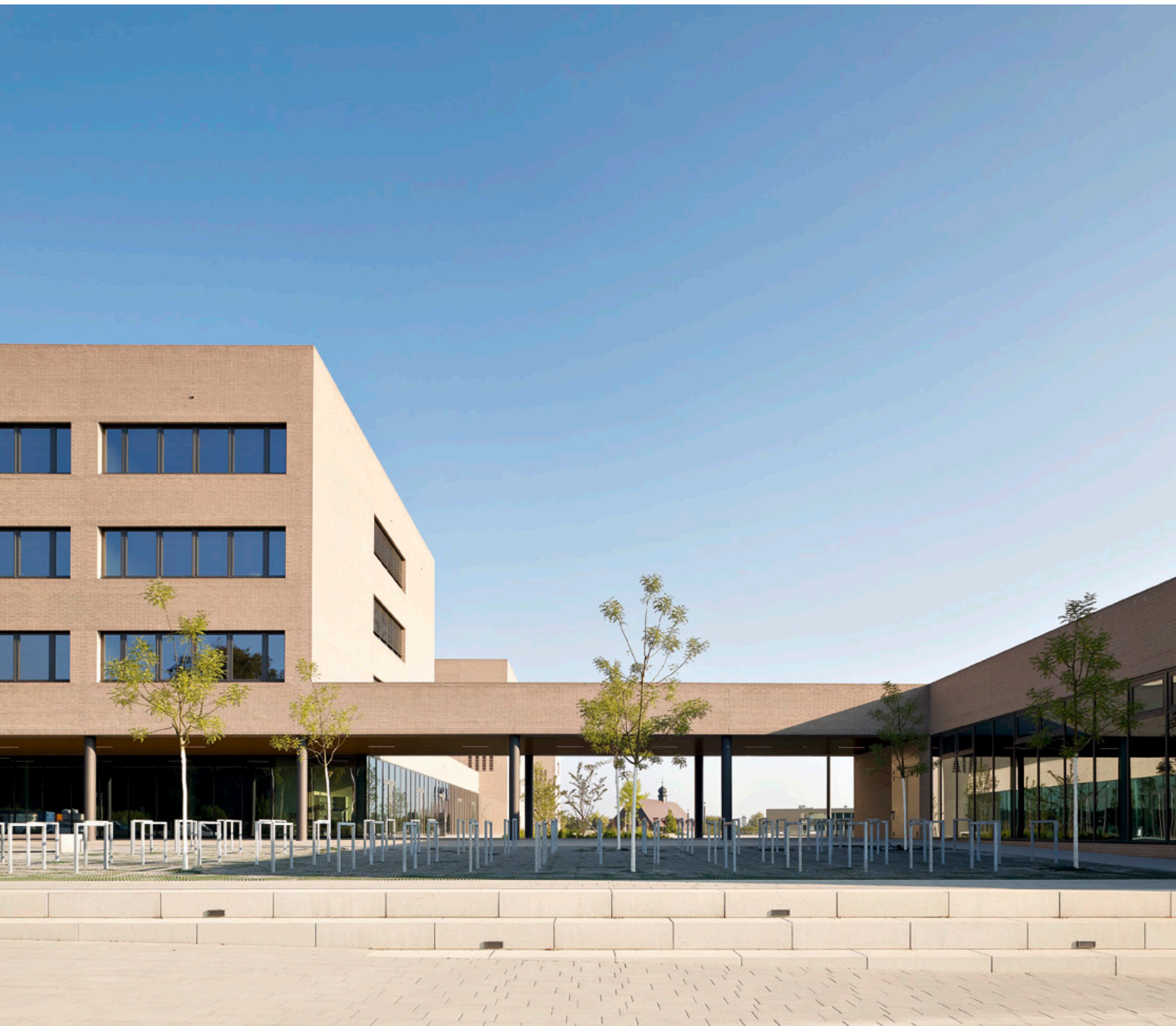
Die graubeige Klinkerfassade aus handgestrichenen Sonderformatsteinen verläuft homogen über das gesamte Gebäude.
